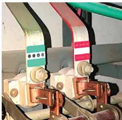
Рис. 2. Контактный термоиндикаторный контроль
