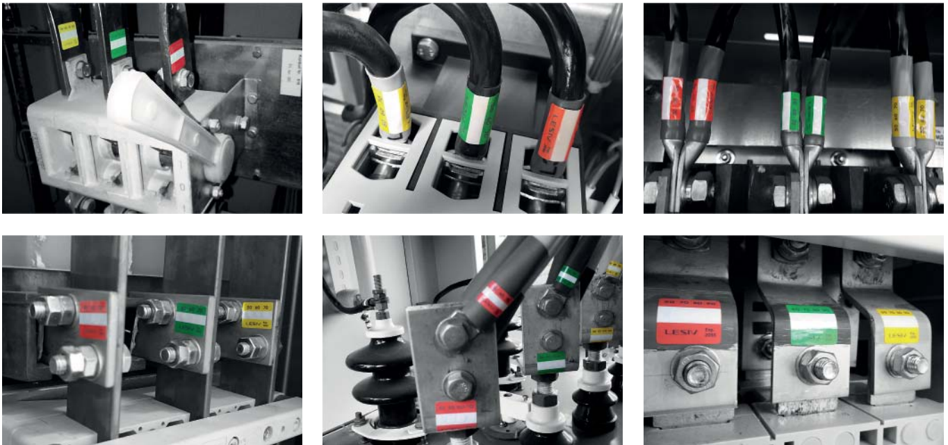
Рис. 7. Примеры установки многотемпературных ТИН
