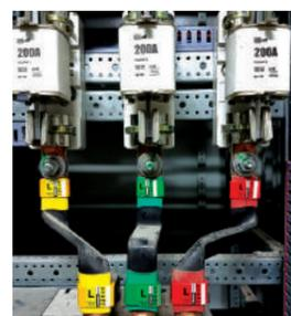
Пример установки ТГН на болтовые контактные соединения
