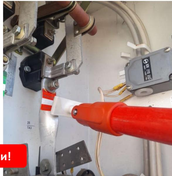
*В качестве объекта для установки термоиндикаторов под напряжением были выбраны РУ 0,4 кВ, ТП 6-10 кВ*
