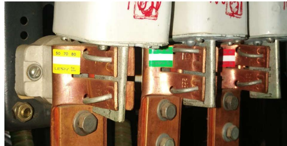
Специалистами ПАО «Россети Московский регион» совместно с ООО «Нилед» и ООО «ТермоЭлектрика» разработана универсальная конструкция для монтажа термоиндикаторов на различные типы контактных соединений электроустановок.
