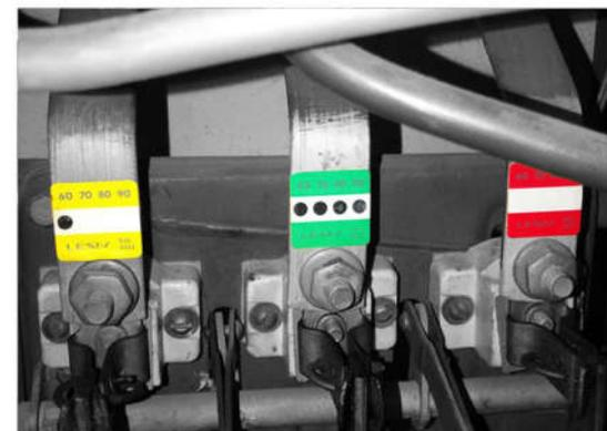
Термоиндикатор непрерывно контролирует температуру контактов и позволяет выявлять дефекты при осмотрах и техническом обслуживании.
