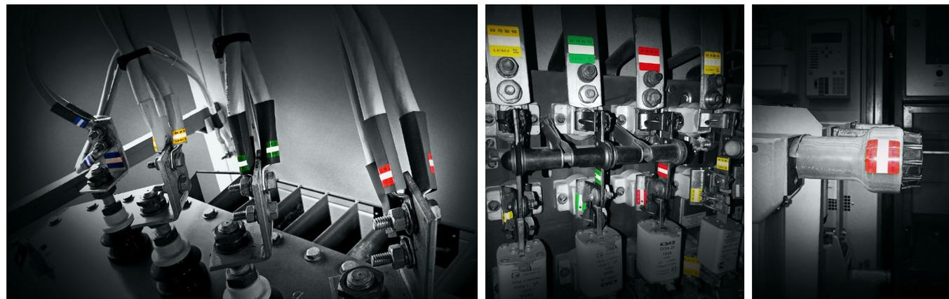
ТЕРМОИНДИКАТОРНЫЙ КОНТРОЛЬ ИСПОЛЬЗУЕТСЯ ДЛЯ КОНТРОЛЯ СОСТОЯНИЯ КОНТАКТОВ И КОНТАКТНЫХ СОЕДИНЕНИЙ В ЭНЕРГОКОМПАНИЯХ РОССИИ.
